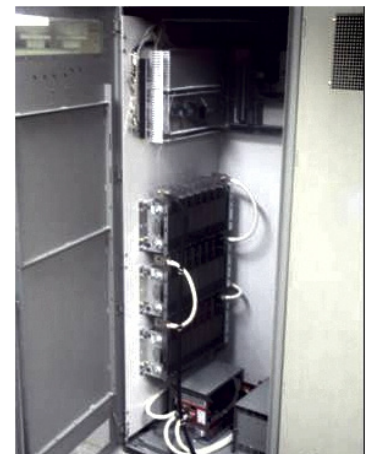
Figura 5: La resistencia de descarga y el módulos DX en el piso del gabinete
