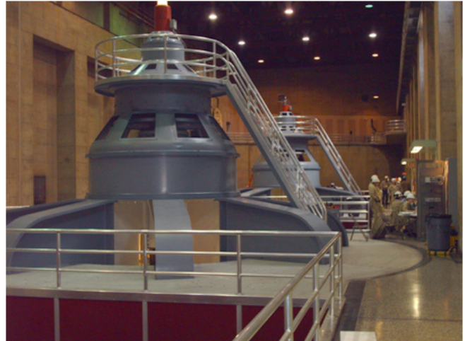
Figura 1: Generador hidroeléctrico de baja velocidad con excitatriz rotatoria
